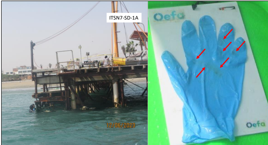
Figura 8.20. Detalles de la verificación mediante buceo del muelle norte de la Fuerza Aérea del Perú de la Playa de Ancón (Según Digesa, playa Esmar 1).
